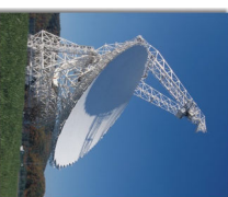
Le télescope de Green Bank, aux USA, avec son diamètre d'environ 100 m, est le plus grand télescope mobile du monde.
