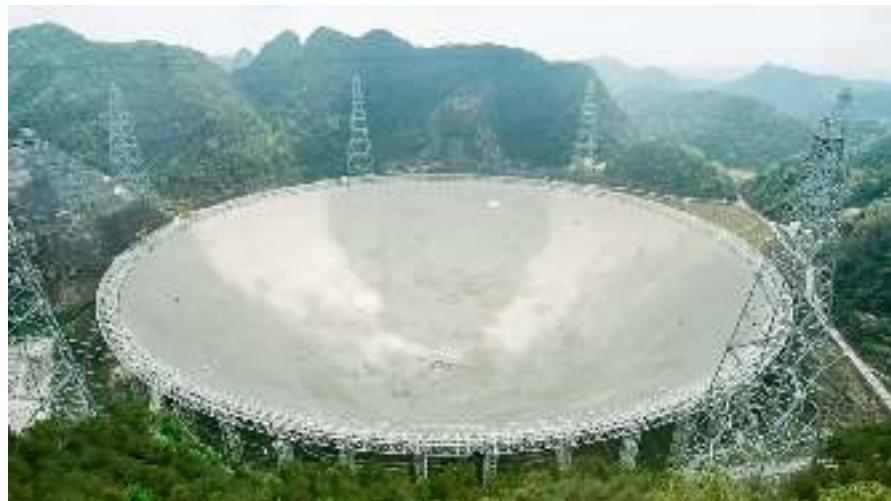
FAST, en Chine, 500 m de diamètre, est le plus grand radiotélescope fixe du monde.
