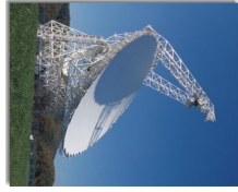
Green Bank Telescope w USA, o średnicy około 100 m, jest największym ruchomym teleskopem na świecie.
