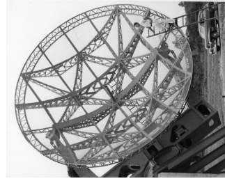
Antena radaru Würzburg
