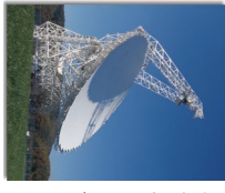
Green Bank Telescope w USA, o średnicy około 100 m, jest największym ruchomym teleskopem na świecie.
