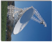
O Green Bank Telescope, nos EUA, com um diâmetro de aproximadamente 100 m, é o maior telescópio móvel do mundo.
